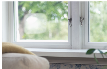
Färdigt montage av Grundels Klimatruta
