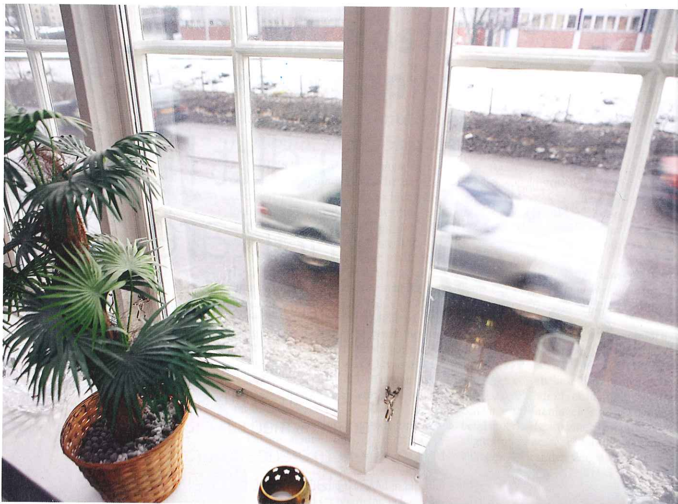
Minskad bullernivå är en av fördelarna med kompletterande isolerrutor.
